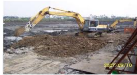
基地整地施工
