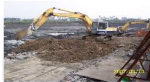
基地整地施工
