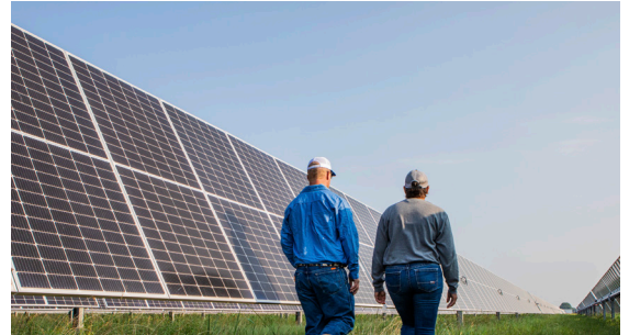
태양광 패널은 낮에 태양을 따라 움직이는데 패널이 최고 높이에 도달했을 때의 높이는 옥수수밭 정도입니다.
